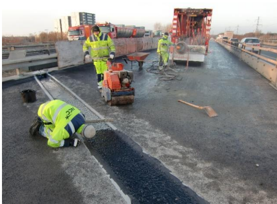
Figur 6. Støbte fuger.
