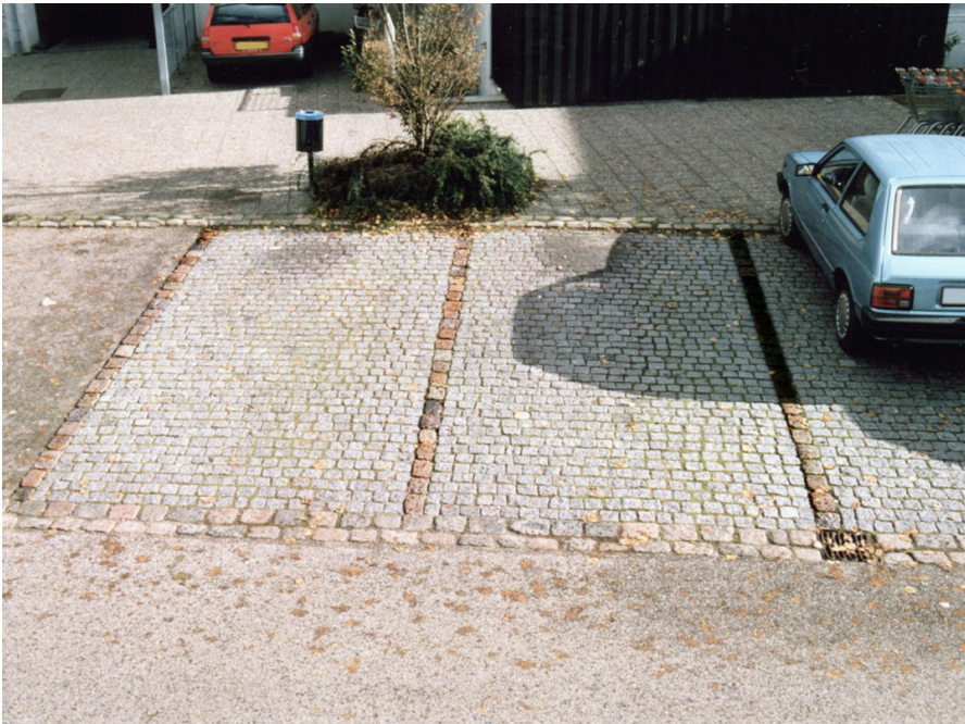
Figur 1.2. Eksempel på parkeringsbåse afmærket med afvigende belægning. Kontrasten mellem den lyse og mørke belægning bør minimum være som på billedet.
