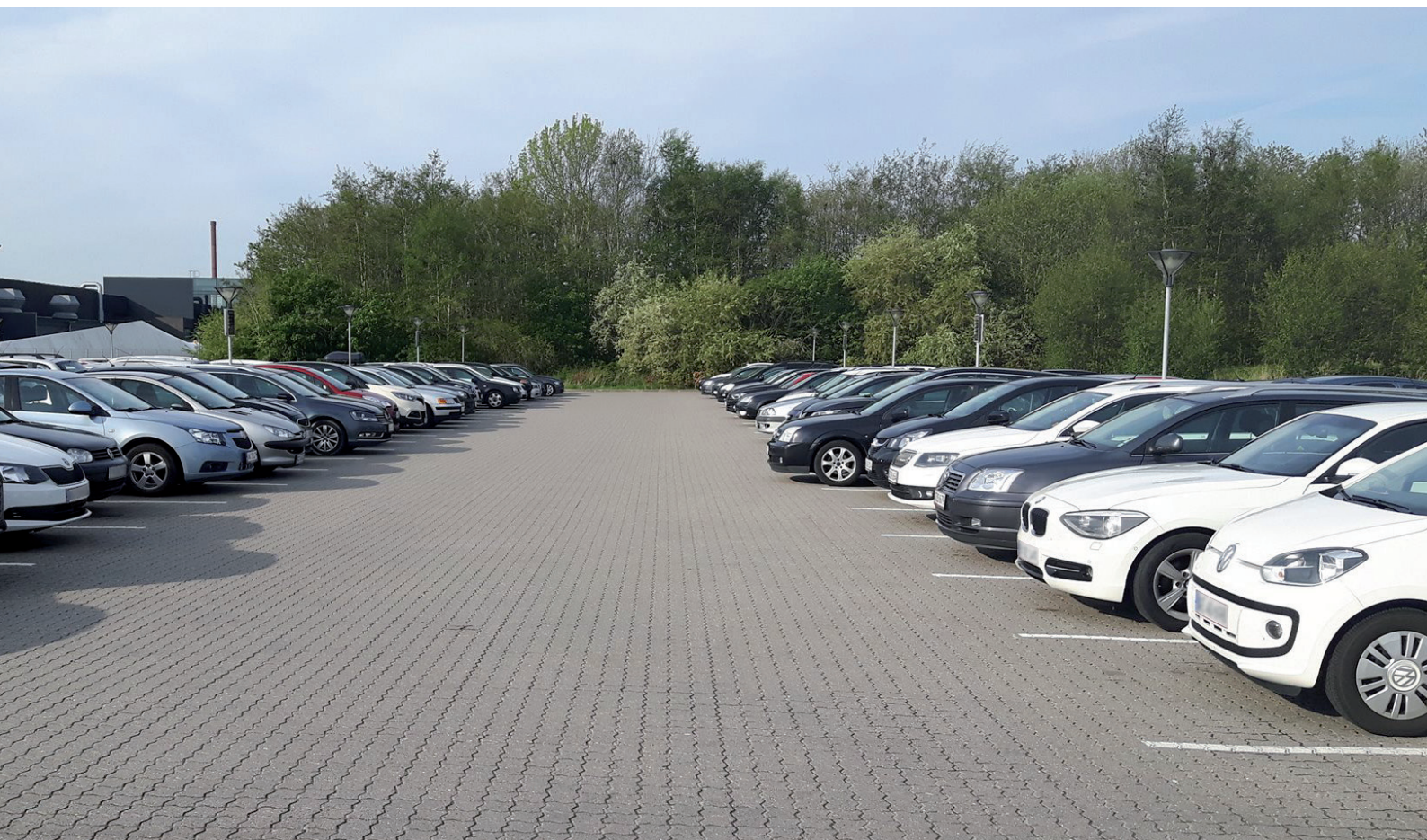
Parkeringsanlæg, hvor bilerne bakker ind.
