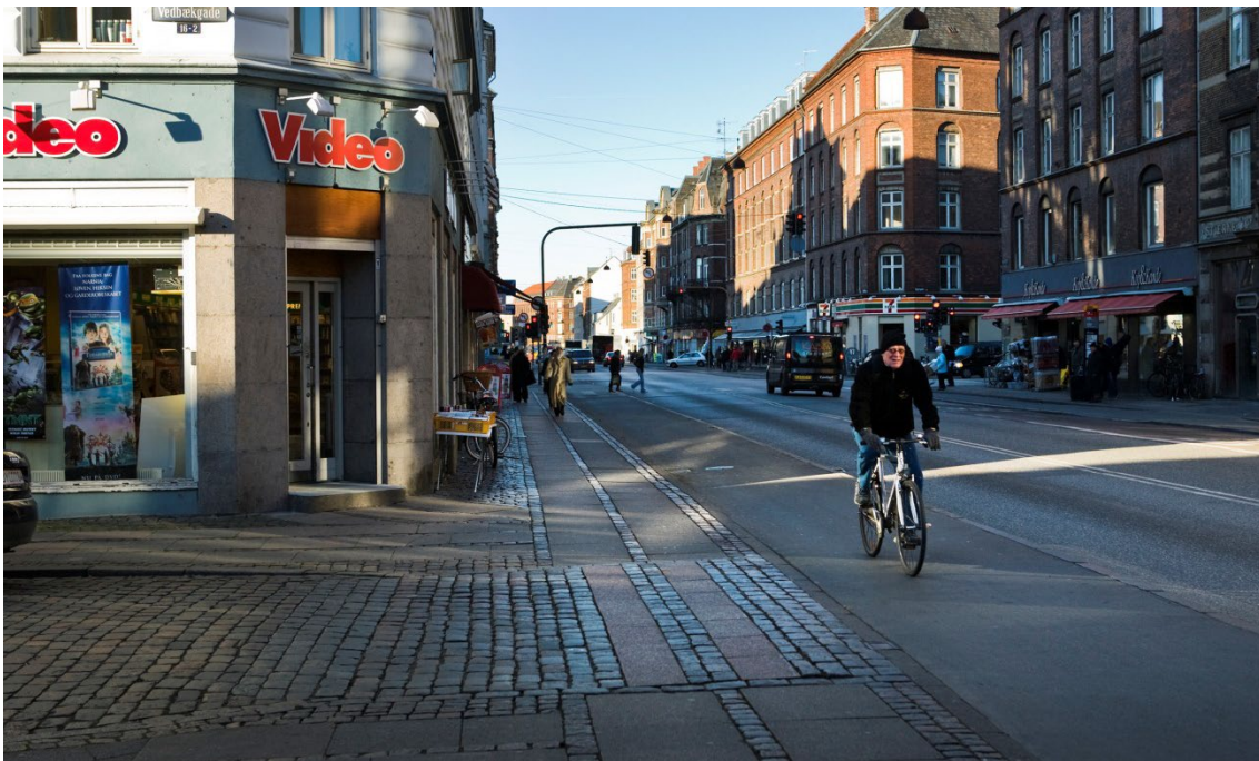
Figur 3.7 Overkørsel. Foto: Christoffer Askman
