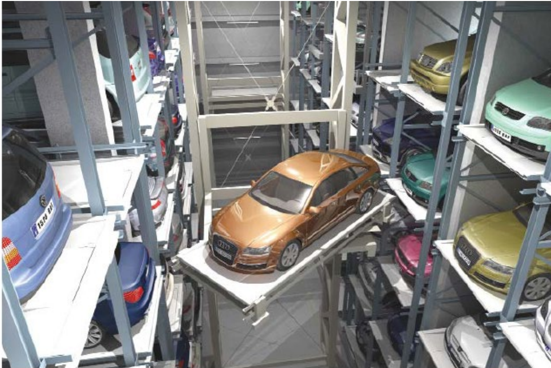
Figur 3.8 Eksempel på et fuldautomatisk parkeringsanlæg.
