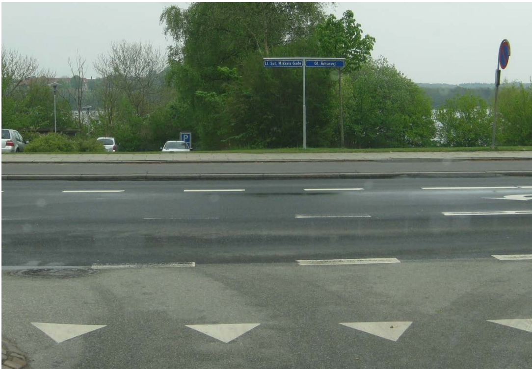
Figur 2.12. Vejnavneskilt på primærvej, der skifter navn ved sekundærvejens udmunding.
