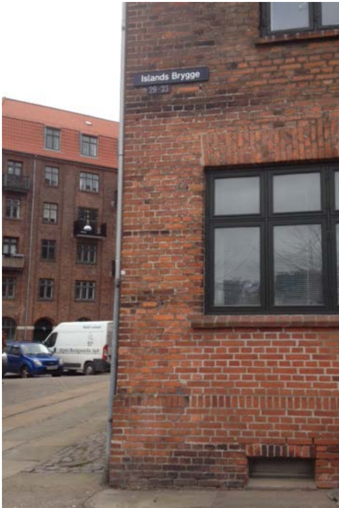
Figur 3.1. Angivelse af husnumre opsat under vejnavneskilt på mur mellem stueetage og 1. sal.
