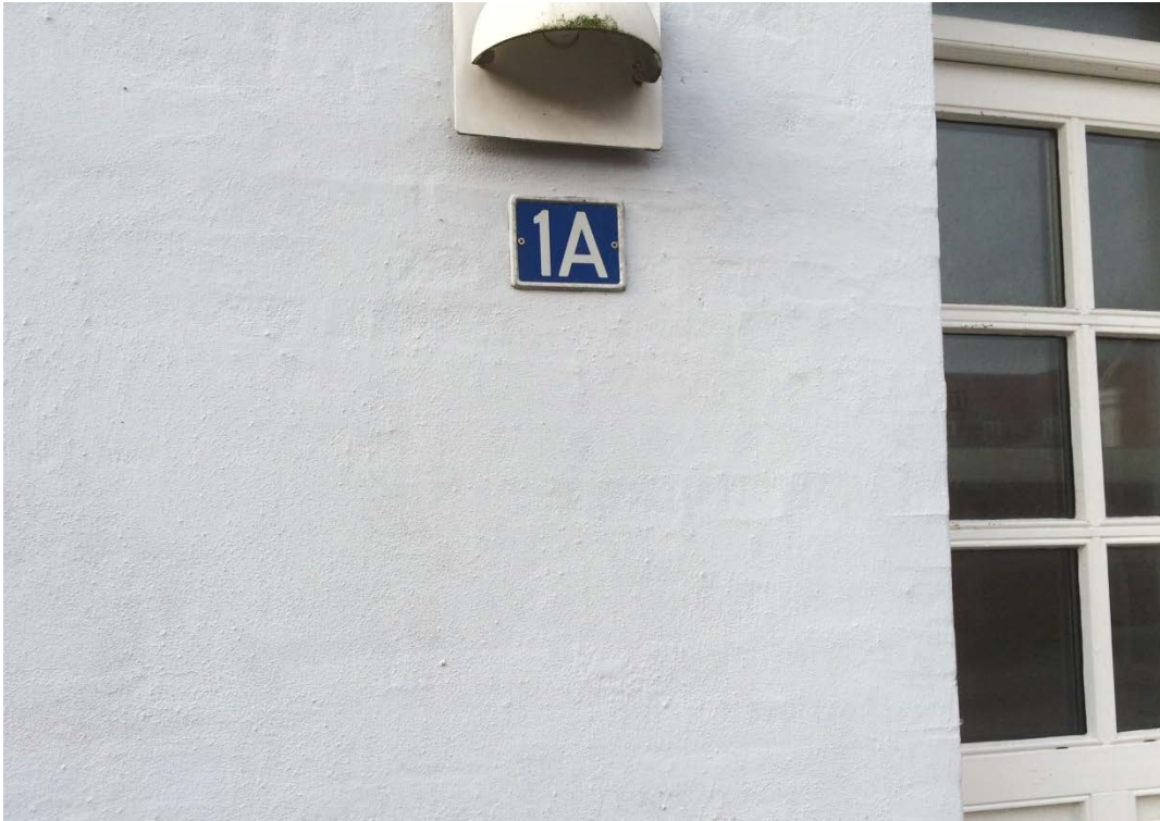
Figur 3.2. Husnummer opsat på mur.
