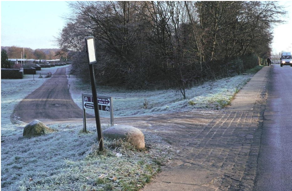
Figur 5.5 Stigning anvendt som fartdæmper
