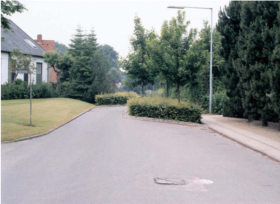
Figur 4.28 Forsætning af indsnævring fra 2 til 1 spor
