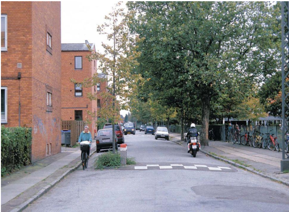
Figur 3.11 Indsnævring til 1 spor med bump
