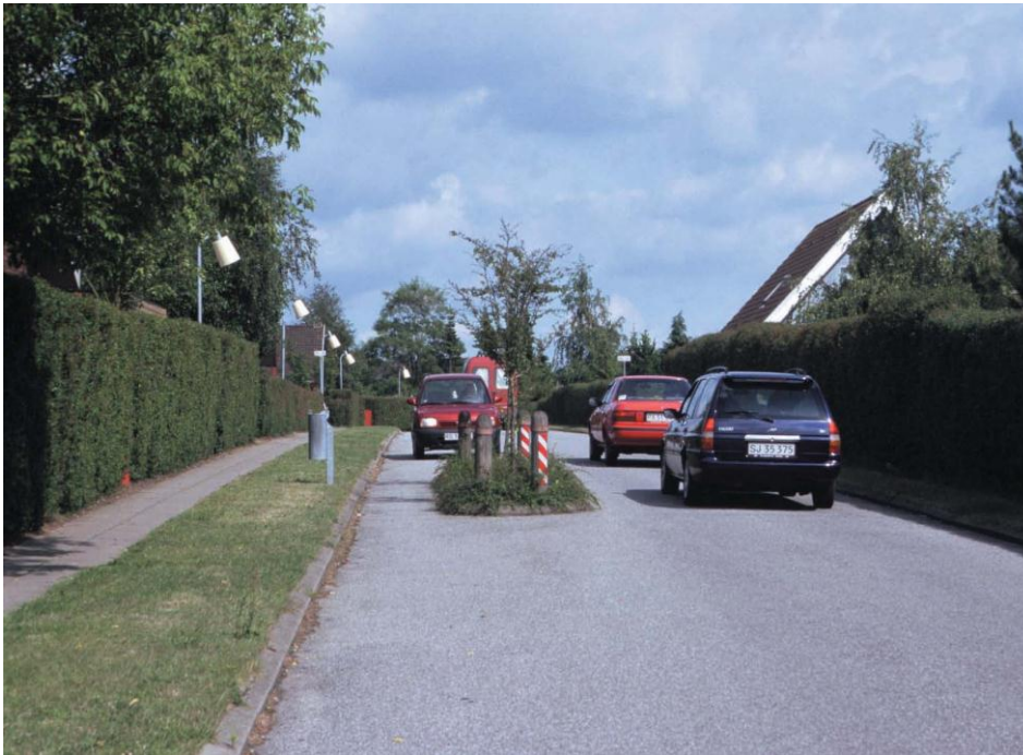
Figur 4.35 Indsnævring til 1 spor
