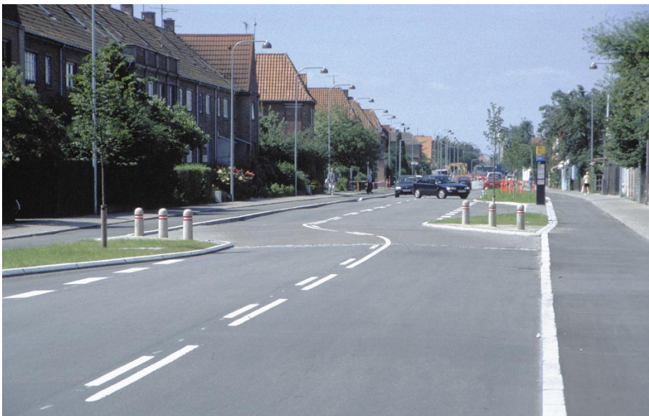
Figur 4.27 Forsætning af kørespor uden indsnævring
