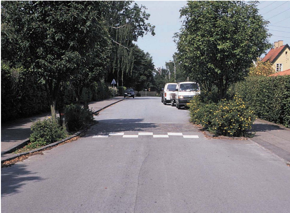
Figur 4.44 Skakbrætarmærkning (S32) på rampe
