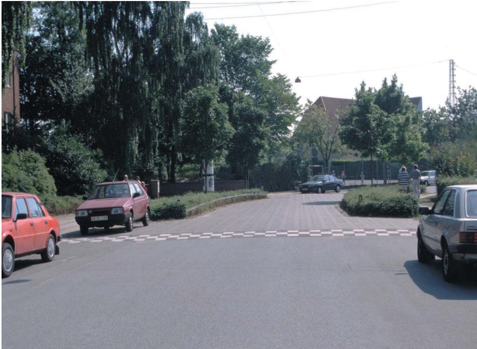
Figur 3.6 Hævet flade med ramper
