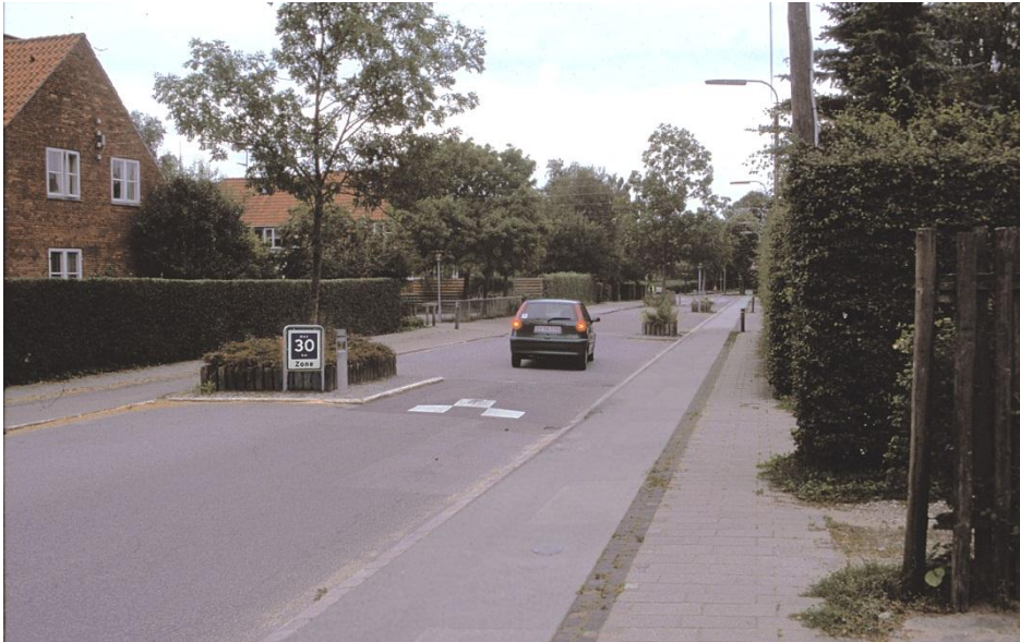
Figur 3.14 Forsætning med indsnævring og bump
