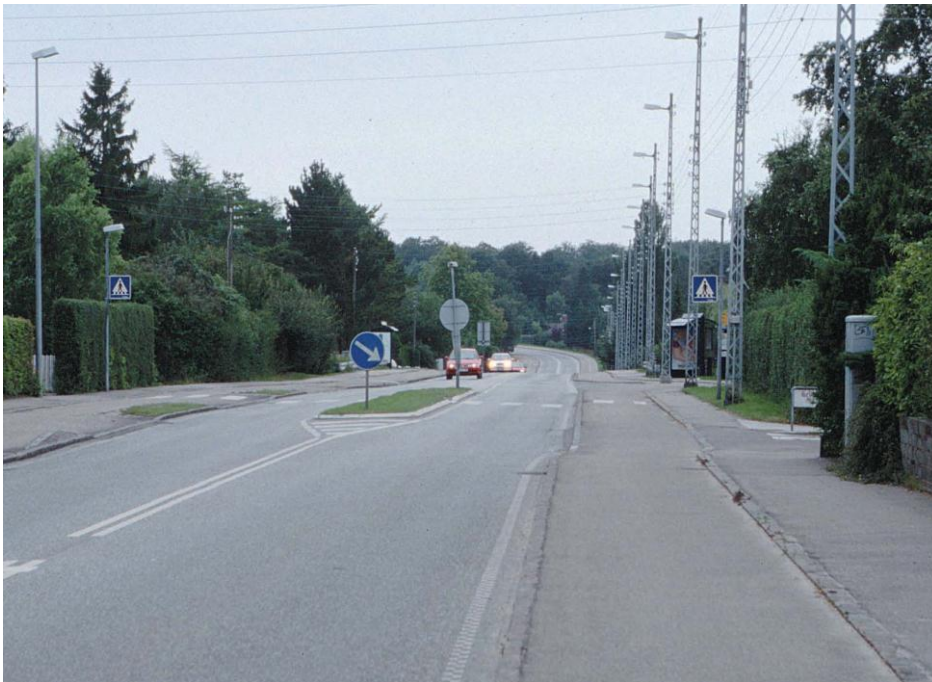
Figur 3.8 2-sporet indsnævring fra vejmidte
