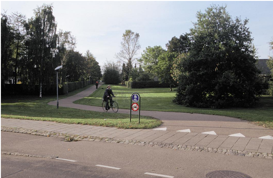
Figur 5.1 Bremsekurve, her kombineret med stigning
