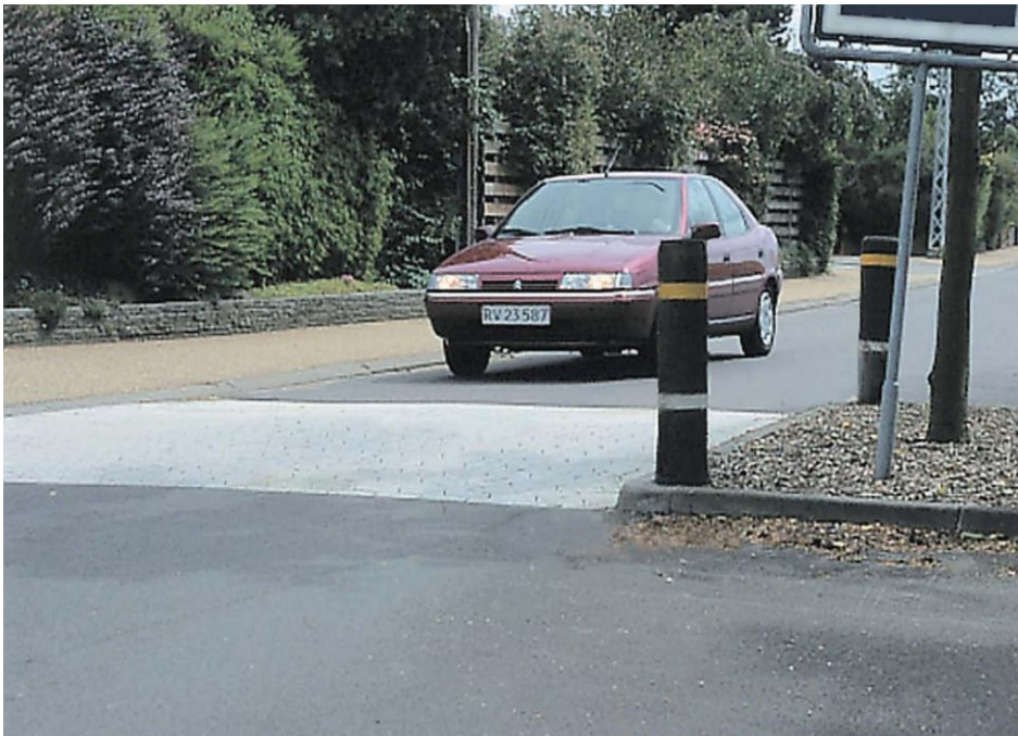
Figur 4.40 Belægningsskift på bump
