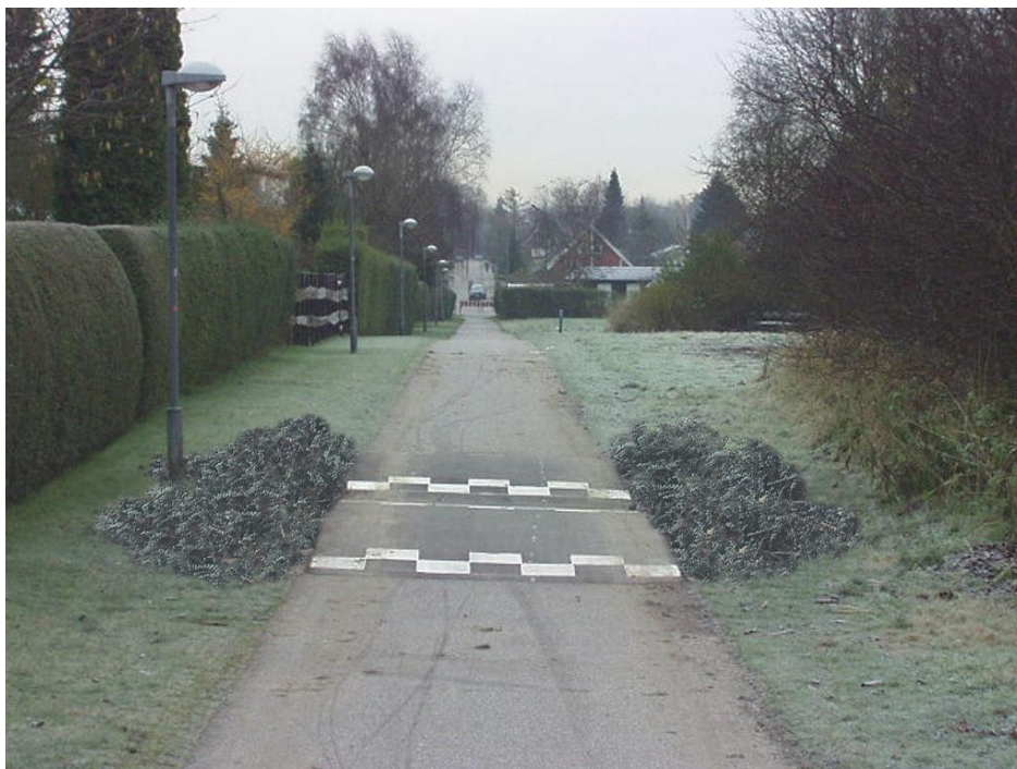
Figur 5.7 Eksempel på knallertbump
