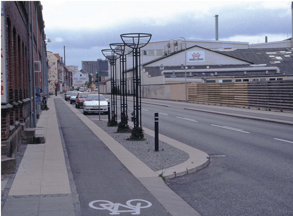
Figur 4.10 Sideheller med rumopdelende funktion
