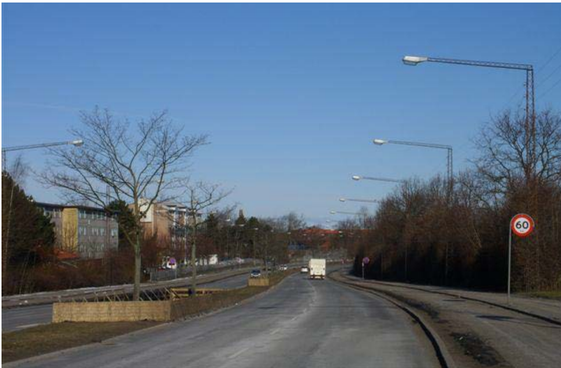
Figur 8.6 Eksempel på indfaldsvej med lokal højere hastighedsgrænse.
