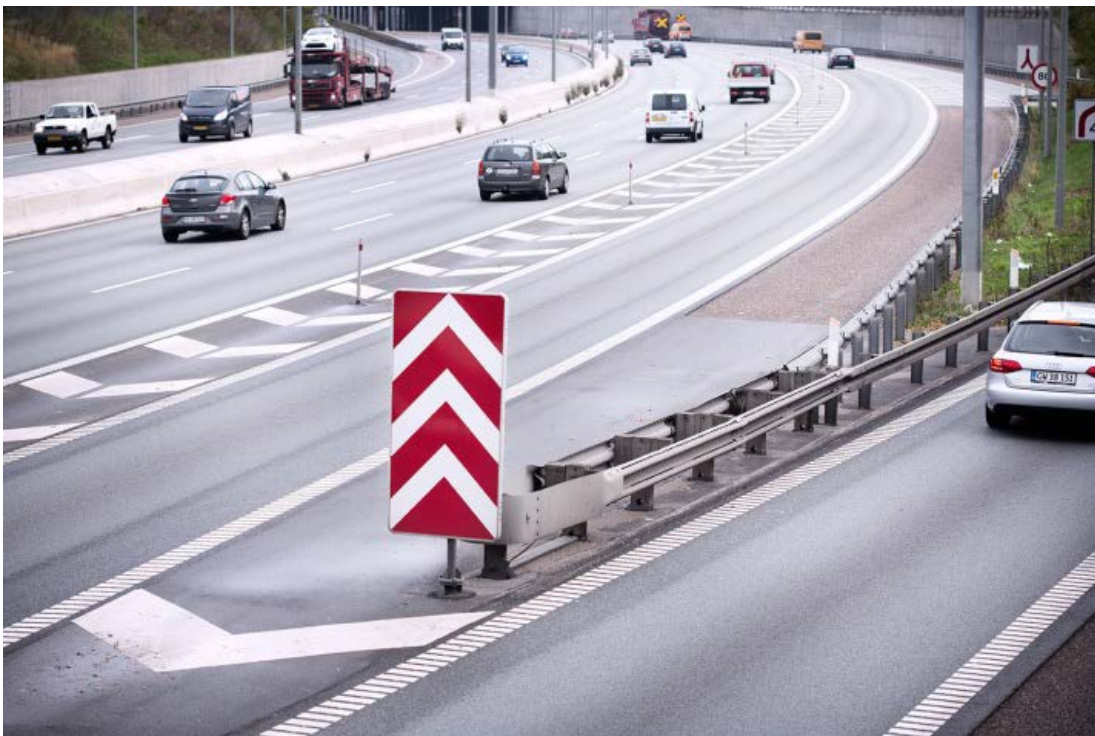
Figur 7.9 Eksempel på en påkørselsdæmper i en kile ved en motorvejsrampe.
