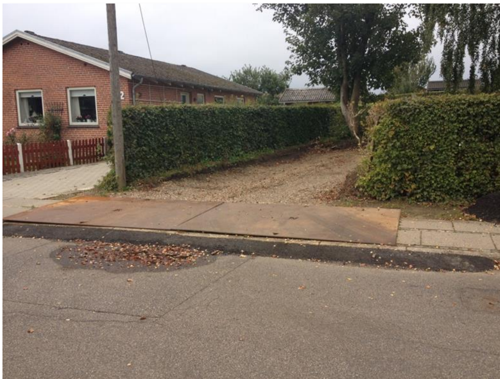
Figur 6 Adgang anlagt uden tilladelse.
