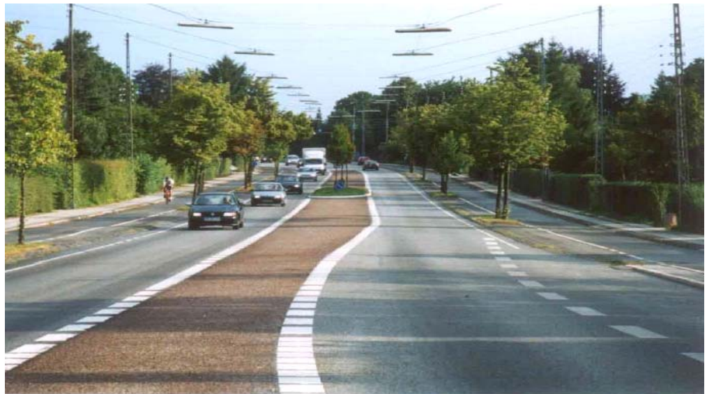
Figur 4.1: Der indgår både små og store hastighedsprojekter og anlægspriserne varierer meget.
